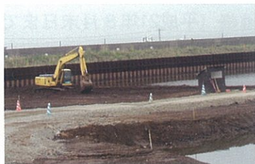
埋立処分作業 (使用重機：バックホウ)
